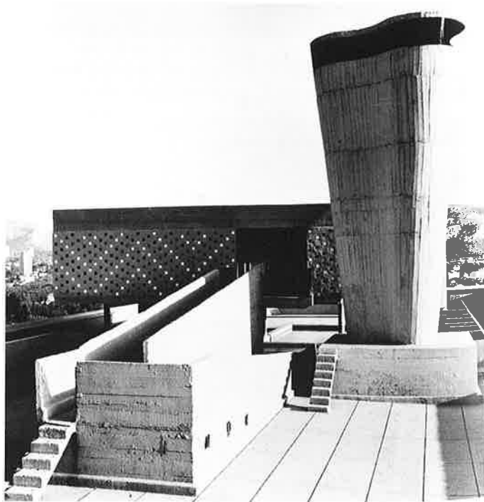
12-99 Roof, Unité d'Habitation
