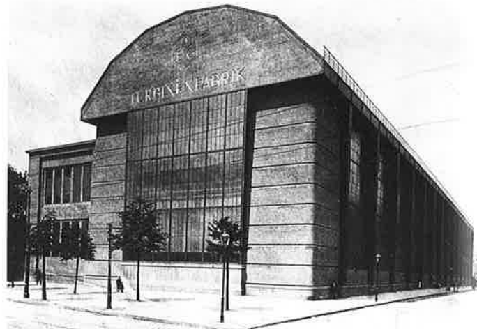
12-60 Peter Behrens. Turbinenfabrik. Berlin. 1909
