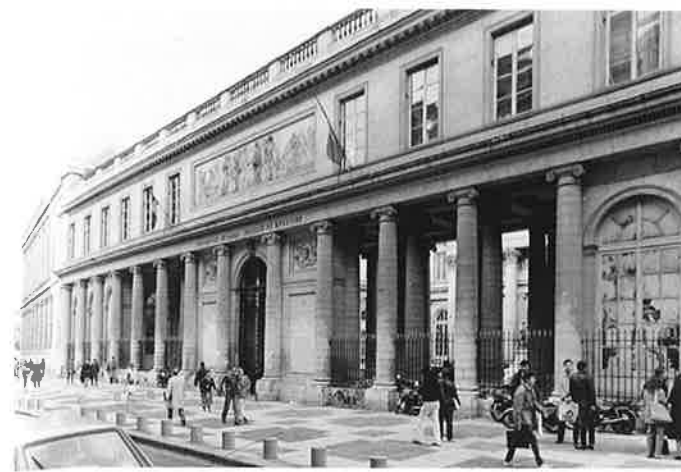
10-35 Street facade, École de Chirurgie
