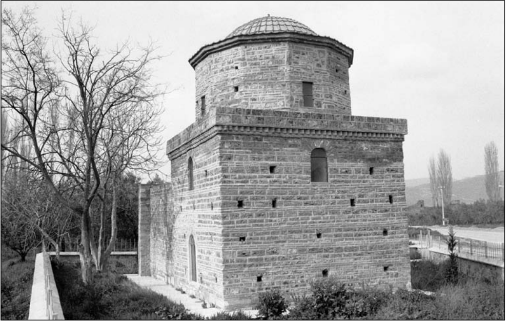
Figure 24: Kırğızlar Türbesi (Anthony E. Baker).
