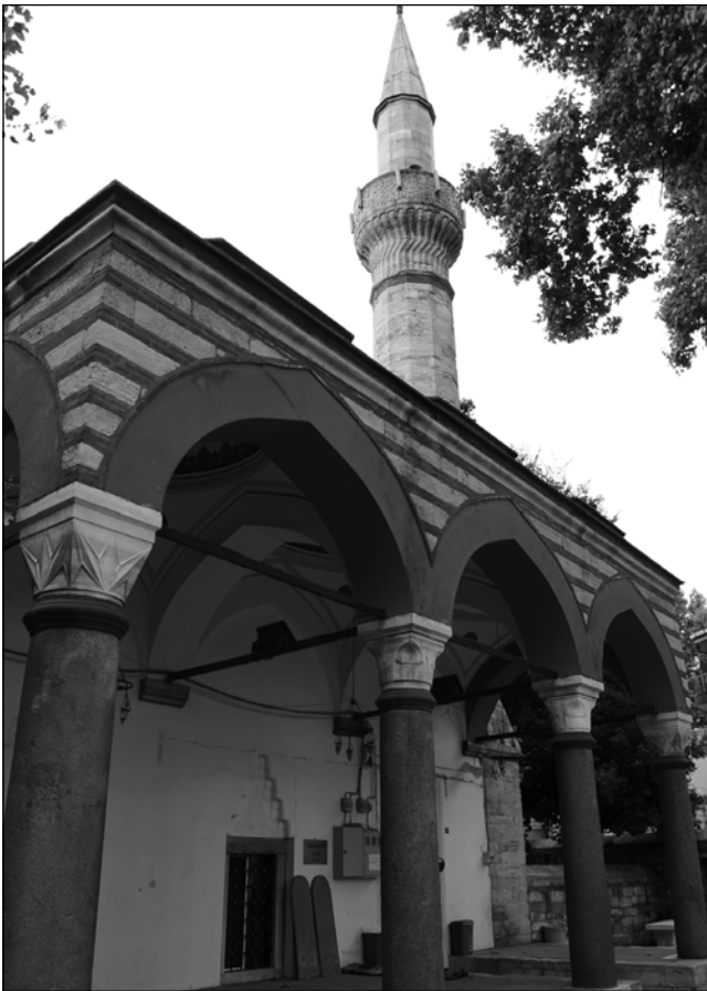
Figure 28: Cezeri Kasım Pasha Camii (Anthony E. Baker).
