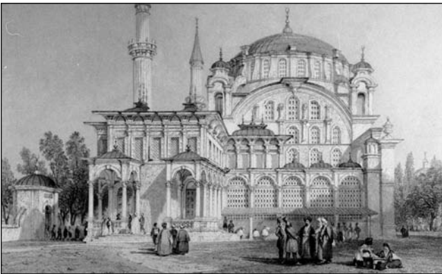
Figure 1: Selimiye Cami, Üsküdar.
