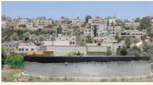
خزان مياه لاغراض الزراعة
