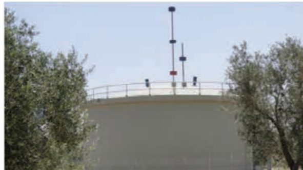
خزان مياه في قباطية
