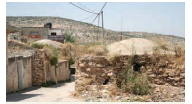
منطقة تاريخية بحاجة لإعادة تأهيل
