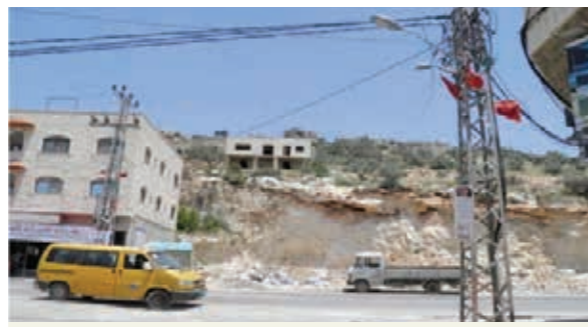
خطوط شبكة كهرباء - قباطية
