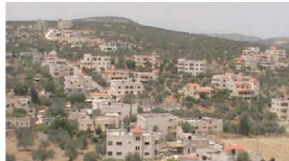
منطقة سكانية متوسطة الكثافة- الزبادة
