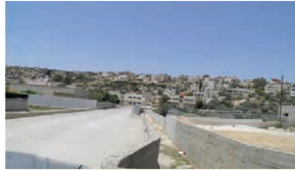
محطة معالجة مياه صرف صحي محطة معالجة مياه صرف صحي
