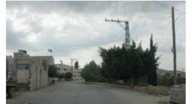
منطقة ذات ضغط مياه غير مناسب (منخفض)
