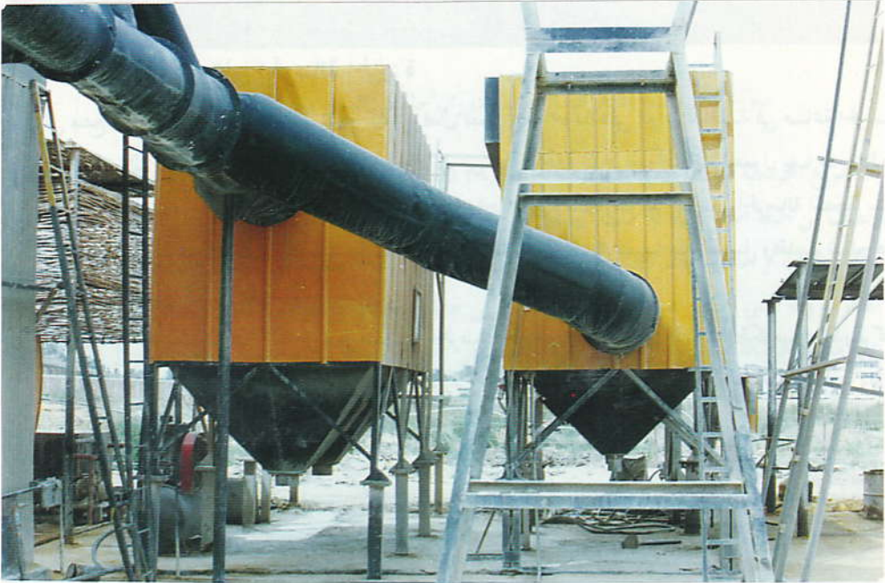
صورة رقم (٩) توضح عدد ٢ فلتر لسحب الغبار والأترربة الناتجة عن العمل من داخل المحطة المركزية
