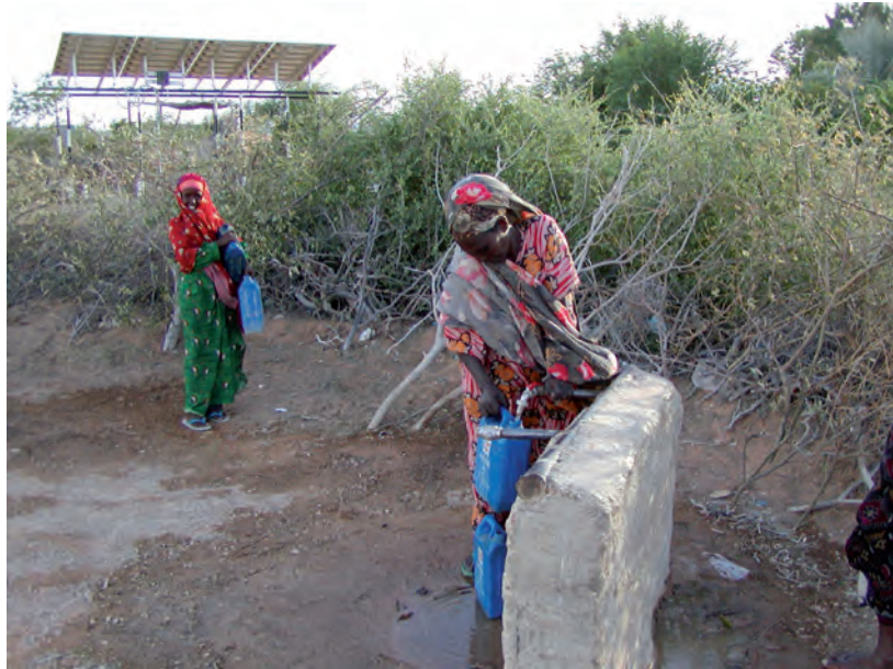
(d) Ten year old solar water pumping system in Puntland, Somalia
