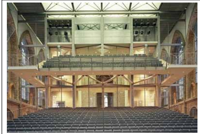
شكل (١٠) مشروع التأهيل يستخدم عناصر إنشائية حديثة في مبنى تاريخي لتوظيف الفراغات. وقد تم تغطية الفناء المكشوف من خلال هيكل إنشائي يتصف بالخفة. يمثل المشروع صالة عرض تقع داخل قلعة Vigevano، وقد كلف المهندس الإنشائي يورينا بتصميمه وتنفيذه عام ٢٠٠٤. المصدر: تصوير الباحث، ٢٠٠٧.
