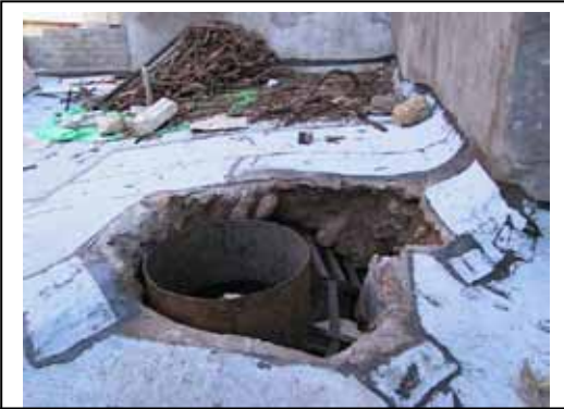
شكل (٣١) فوهة مخزن المحرقة خلال معالجة الانهيار في أعلاها تصوير الباحث، ٢٠٠٠
