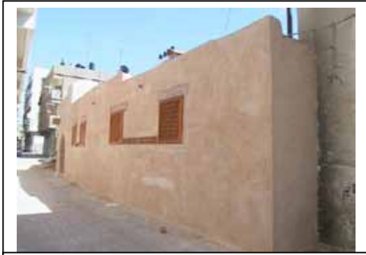
شكل (٢٧) الواجهة الخارجية بعد الترميم تصوير الباحث، ٢٠٠٠
