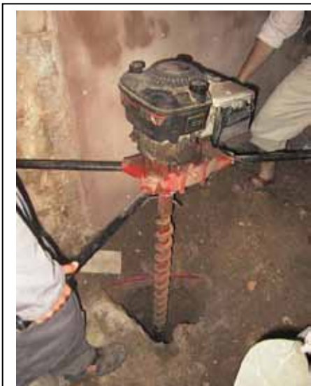
شكل (٧) جهاز حفر استخدم لأخذ عينة جوفية تصوير الباحث، ٢٠٠٠
