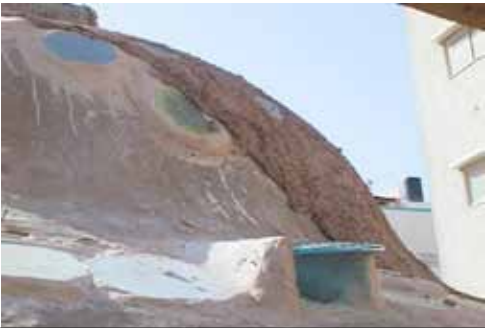
شكل (٢١) معالجة فتحات القبة بالزجاج، وتغطيتها بالعازل المائي. تصوير الباحث، ٢٠٠٠
