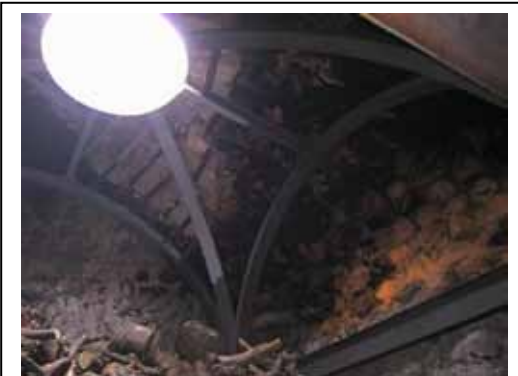
شكل (٣٢) تطبيق هيكل إنشائي لدعم الفوهة وجدران مستودع الحطب تصوير الباحث، ٢٠٠٠
