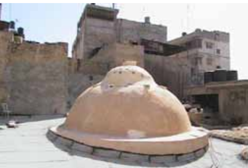
شكل (٢٢) القبة الرئيسية بعد الترميم تصوير الباحث، ٢٠٠٠
