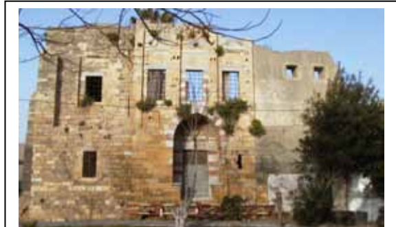
واجهة المبنى الجنوبي قصر آل الرضوان ، غزة. المصدر: تصوير الباحث ٢٠٠١ ضمن مشروع الحفاظ وتأهيل القصر ، برعاية الأمم المتحدة UNDP
