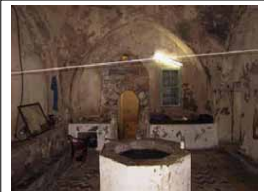
شكل (٢) القاعة الوسطى الباردة في الحمام، تظهر القسارة الإسمنتية والتشوهات المختلفة التي غطت على المواد الأصلية المستخدمة في الجدران. تصوير الباحث، ١٩٩٩
