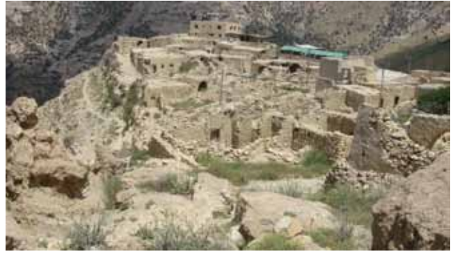
شكل (٢) (قرية ضانا في محافظة الطفيلة ، الأردن ) ، دمار جزء كبير من القرى التراثية الأردنية بسبب هجرة سكانها في ظل نقص الخدمات العامة وقصور مخططات الحفاظ على مستوى المحافظات والأقاليم. المصدر: تصوير الباحث، ٢٠١٠
