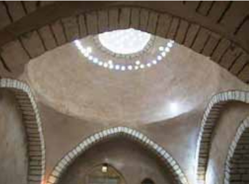
شكل (٢٠) طراشة القبة باللون الوردي الناتج عن حبيبات الفخار المكسر والذي تم خلطه مع الجير والماء المقطر تصوير الباحث، ٢٠٠٠
