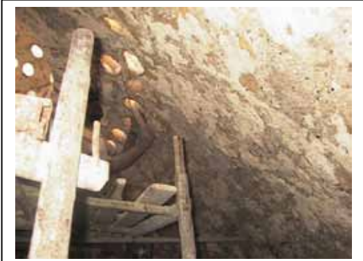
شكل (١٣) سطح القبّة قبل تطبيق القصارّة تصوير الباحث، ٢٠٠٠
