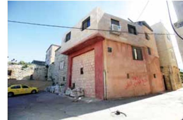
البيت الفلاحي (C7): صورة للمبنى عام 1994 وصورة للمبنى عام 2012 بعد إزالة نضبة الترميد وإضافة طابق علوي على المبنى التاريخي
