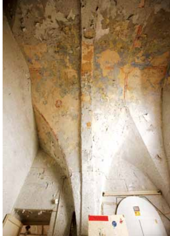
آثار الرطوبة في العقود في مبنى (A10) نتيجة قلة الصيانة الدورية، وطرق الصيانة الخاطئة بسبب استخدام مواد حديثة غير مناسبة في القفصاة والطرشة الداخلية للعقود
