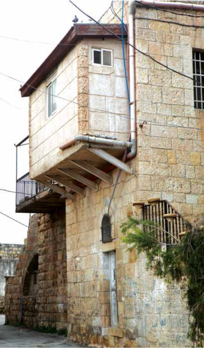
يلكونة المبنى (G3) والتي تم إزالة معظم عناصرها ولم يتبق سوى الدوامر الحديدية واستبدل حديد الحماية بمواد حديثة لا تتناسب والقيمة التاريخية للمبنى.
