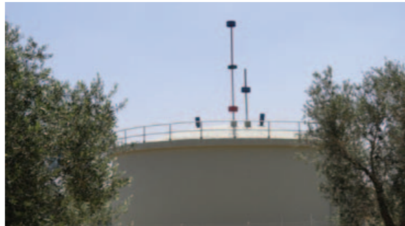
خزان مياه في قباطية
