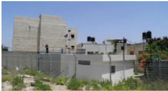
محطة تعزيز ضخ المياه في قباطية
