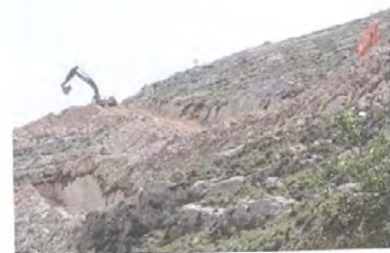
(d) Excavations for segregation wall.
