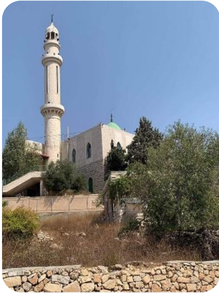
الصورة(13):مسجد في بيرزيت, (الزيارات الميدانية ، 2020)
