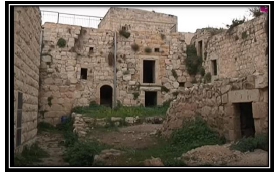
الصورة(20):احواش في بيرزيت، (الزيارات الميدانية ، 2020)
