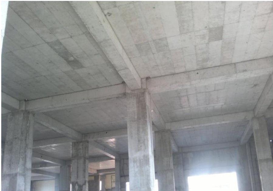
ارضيات بجسور / Beam & Slab/
